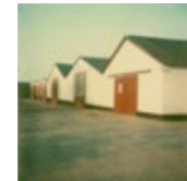
Bouw nieuwe werkplaats in Achtmaal
