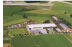
Uitbreiding fabrieksruimte Achtmaal
